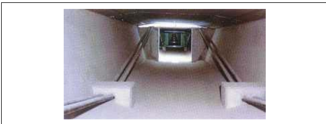
Figura 3.2 – Protensão externa (Viaduto Lesnica, Slovenia) Fonte: < www.bbr-conex.hr/eng/spec-appl/ext-prestres.htm >
