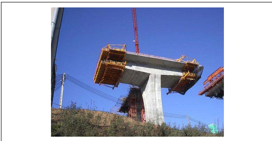
Figura 2.3 – Aduelas moldadas no local Fonte: <www.roadtraffic-technology.com>
