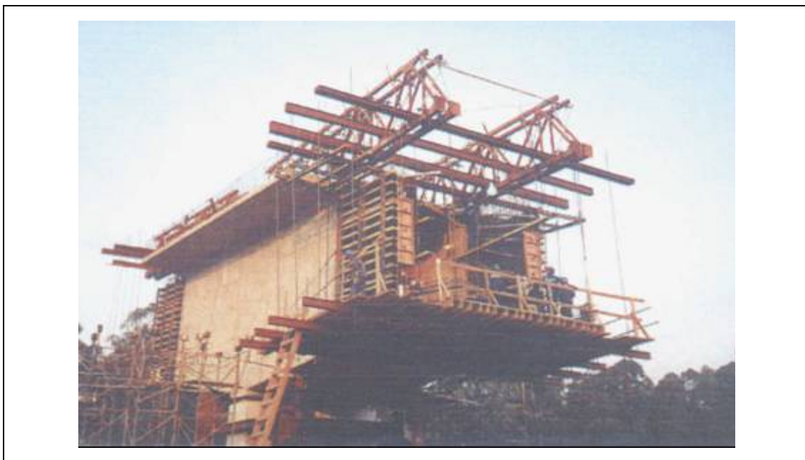
Figura 2.1 – Viga em balanços sucessivos Fonte: <Catálogo Somaq>
